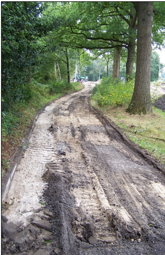
Afbeelding 1 Voorbeeld van een vergelijkbare situatie waarbij een fietspad naast bestaande bomen wordt aangelegd. Alleen de strooisellaag wordt afgegraven. Het 'zwevende' fietspad komt boven op de bestaande boomwortels te liggen.
